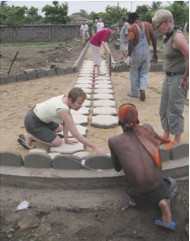
Karin Widing ja Kaisa Lindström asettelivat laattoja betonimestari Boris Azianoun kanssa.
