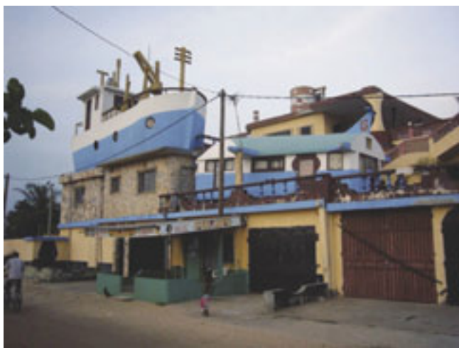
Valok. Gunnel Adlercreutz
